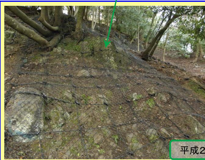
ロープネット工により、剥離を防止し、現地に固定する。
