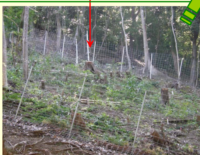
【平成22年9月10日の状況】 植栽木の活着状況は、良好であった。
