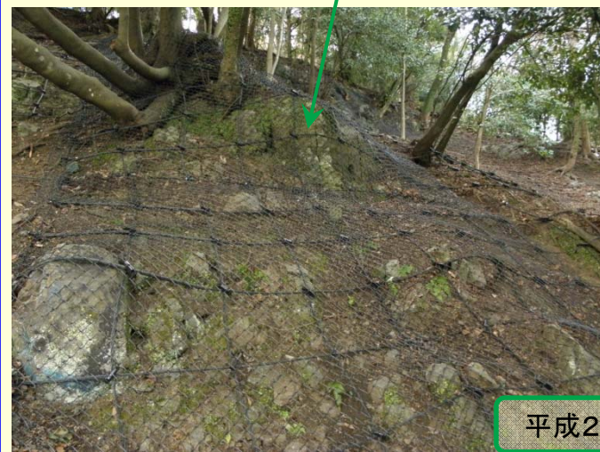
ロープネット工により、剥離を防止し、現地に固定する。
