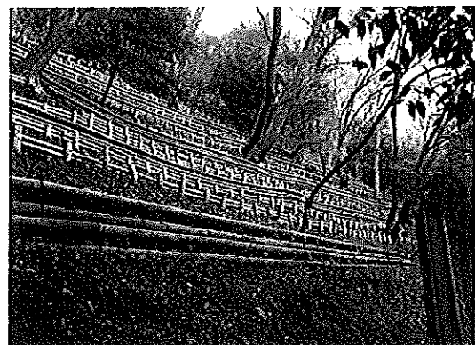
【間伐材を活用した山腹工】
