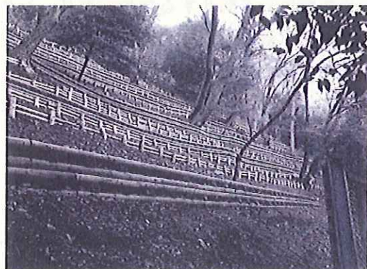
【間伐材を活用した山腹工】
