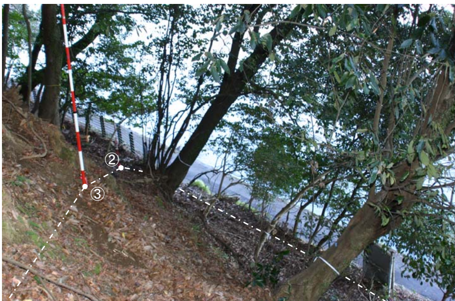
測点③から測点②方向の状況
