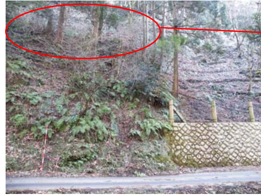
(工事着手前の状況)
