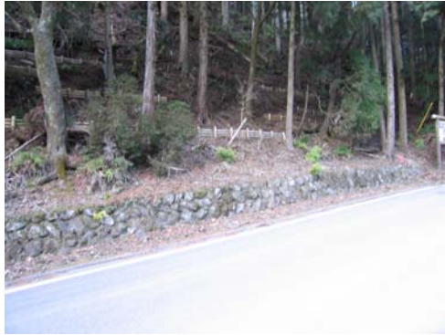
③倒木整理、丸太筋工により保全を図る
