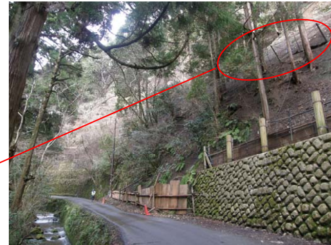
(工事実行中の状況)
