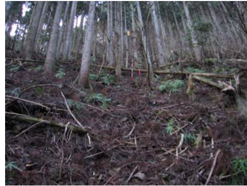
③倒木整理、丸太筋工により保全を図る
