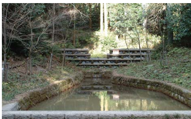
林内に設置した防火貯水槽
