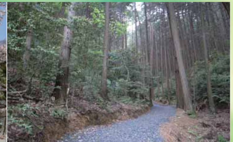
高台寺山国有林内に設置した作業道
