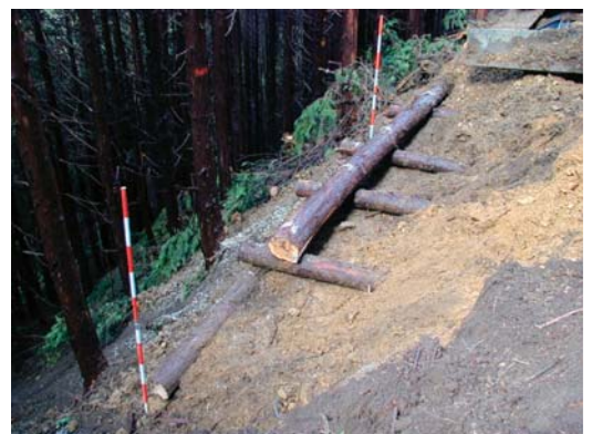
路肩は支障木を利用した丸太組で補強
