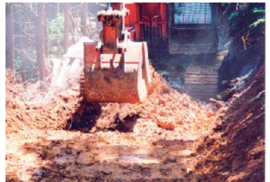
かく拌（生石灰系土壌改良材を混ぜ合わせる）
