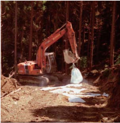
生石灰系土壌改良材の散布
