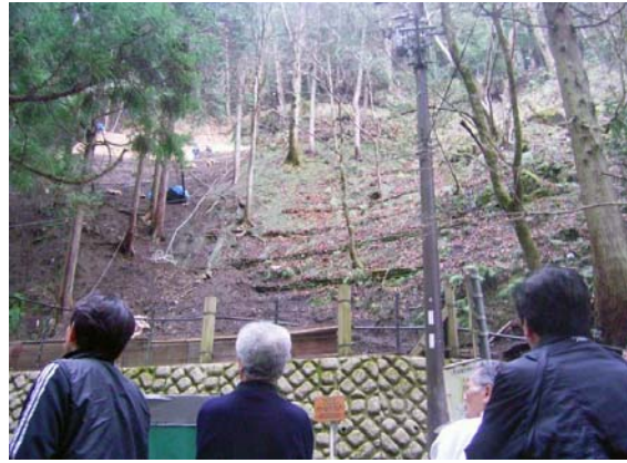
治山工事箇所の様子
