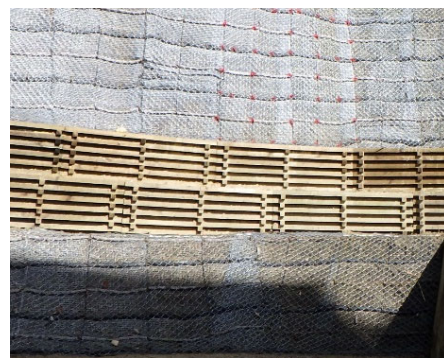
木製柁筋工の設置(近景)
