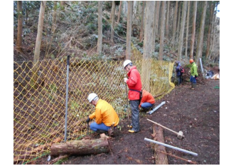
シカ防護柵の補修
