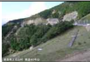
奈良県上北山村 県道40号沿
