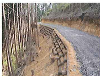
(作業道の作設状況)
