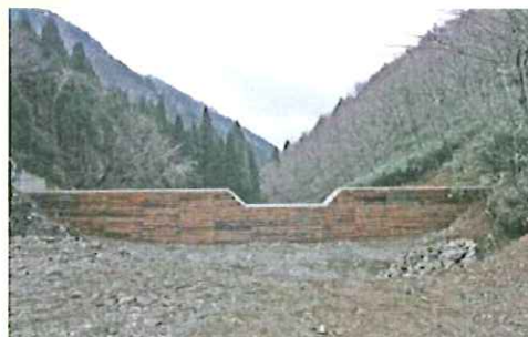
(岡山署：木製型枠を利用した谷止工)
