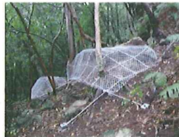
（ワイヤーネット伏工の様子）
