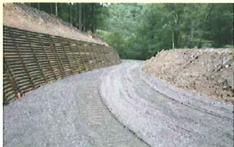
(兵庫署：林道法面への丸太積工)
