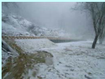
(19年度完成の工事)
