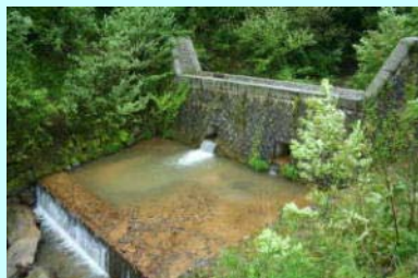
(下流の国交省砂防ダムの様子)
