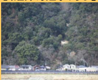
木柵の設置と間伐の実施箇所（たつの市）
