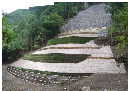
間伐材を利用した山腹工
