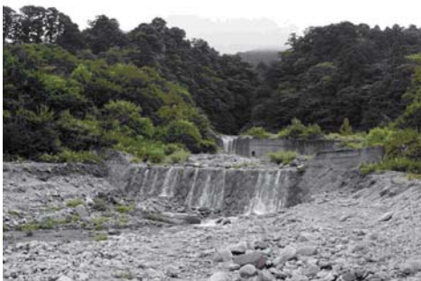
大山では大正6年から治山対策に取り組んでいます。写真は、大正10年に設置した練石積のえん堤（昭和40年補修）です。
