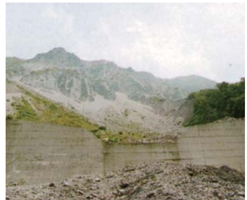
崩落した土砂を固定するために、大崩壊地の脚部に設置した谷止工
