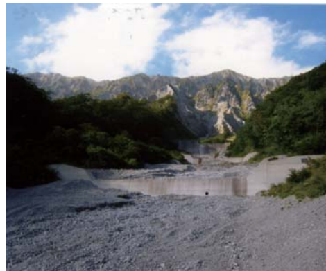
流れ出した土砂の勢いを抑え、新たな土砂流出を防ぐために、沢筋に設置した床固工
