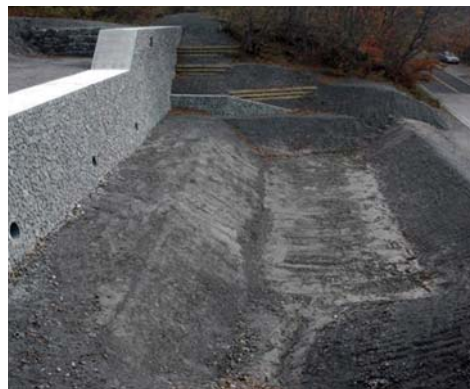
鳥取森林管理署では、環状道路を管理している鳥取県と連携し、道路への土砂流出を減らすため、道路上流側の沢の流路内に、流れてきた土砂を貯めるポケットを設置しました。
