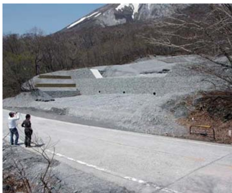
融雪時、流れ出した土砂はポケットに貯留され、道路への流出が防げました。貯まった土砂は鳥取県が取り除き、土砂流入に備えます。
