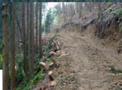
路網作設後の状況
