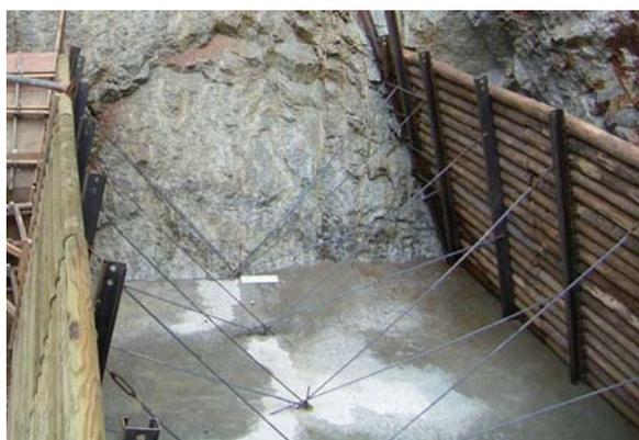
コンクリート型枠に間伐材丸太を使用
