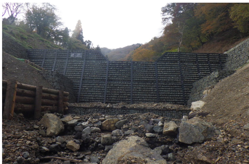
施工後の完成写真
