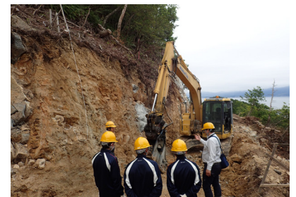
林業専用道施工現場の見学
