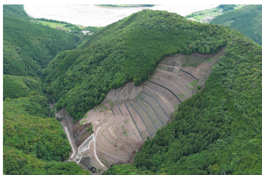
復旧が進む 下モ谷西側地区
