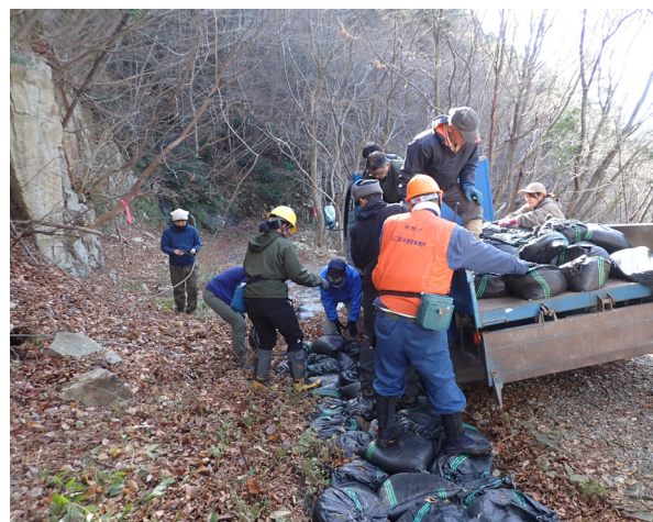
寂地山に至る林道整備の様子
