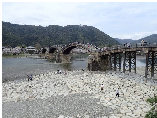
錦帯橋と城山 しろやま 国有林
