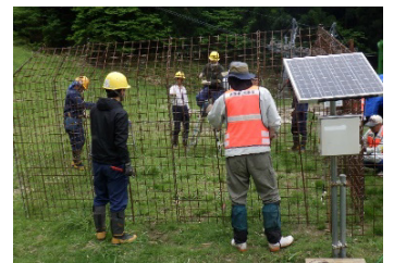
米原市との協定に基づく ICT 囲いわなの設置状況
