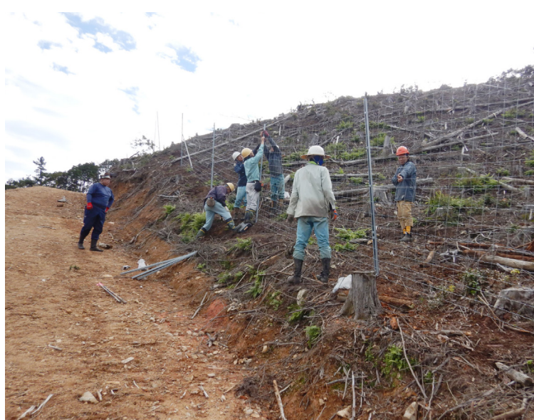
鋼製ネットの設置作業
