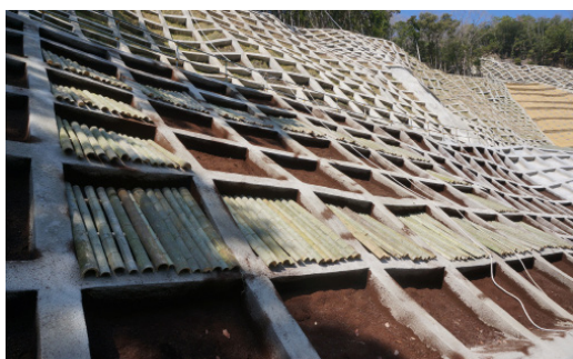
（ア）竹を使用した新たなシカの侵入防止対策、施工当時の様子（平成 30 年撮影）
