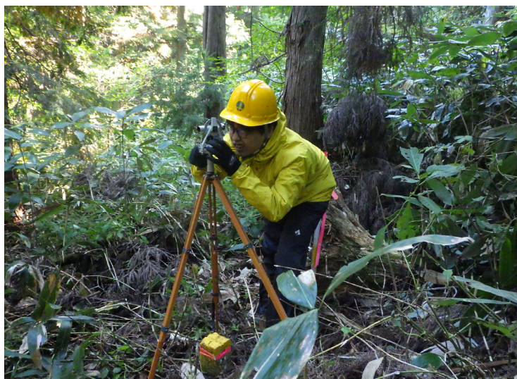
OJTによる境界確認作業の様子
