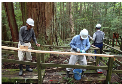
スロープ修繕の様子
