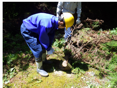
林道支障木の処理
