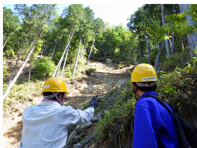
山腹崩壊地の確認
