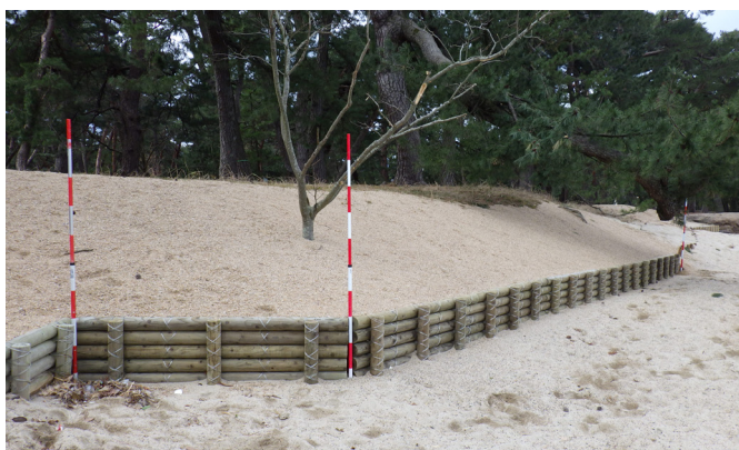
砂の流出を防ぐ養浜工（松原国有林）
