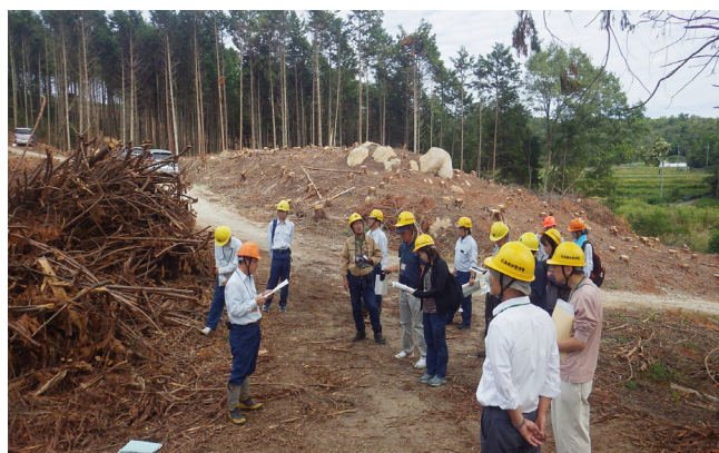
木材生産事業箇所における説明の様子
