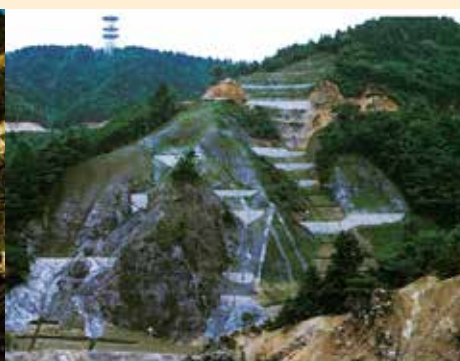
治山工事の施工状況
