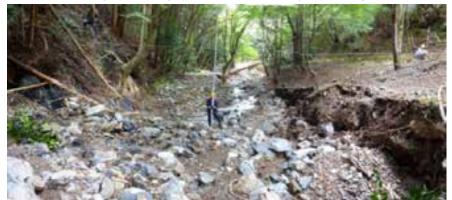
【平成25年台風18号災害による溪流荒廃の状況】 （滋賀県大津市 関寺国有林）
