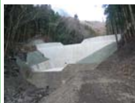
【災害復旧事業により完成した溪間工】 （十津川地区民有林直轄治山事業 奈良県十津川村）
