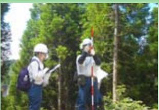
計画路線の縦断勾配を測量
