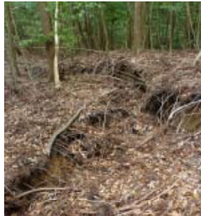
クラック（裂け目）の様子
