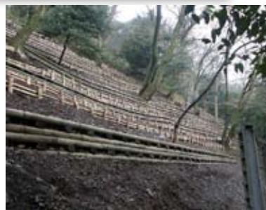
間伐材を活用した山腹工（京都大阪所管内）
