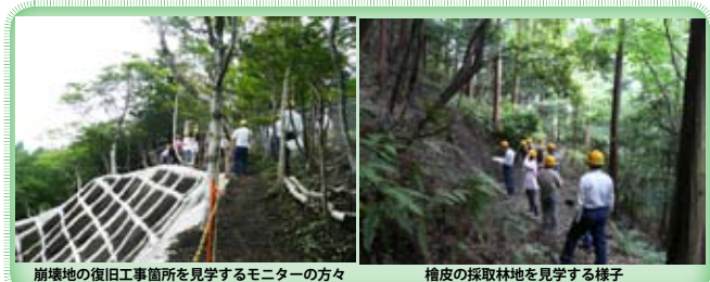
崩壊地の復旧工事箇所を見学するモニターの方々
