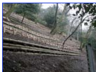
間伐材を活用した山腹工（京都大阪所管内）
