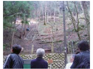
地元住民と治山工事現場を見学する様子
