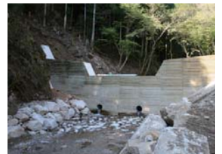
間伐材を利用した谷止工
