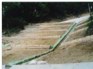
間伐材を利用した山腹工
