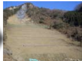
国有林野内直轄治山事業による落石災害の復旧
