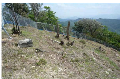
周囲に防護柵設置（大塔山山頂）
