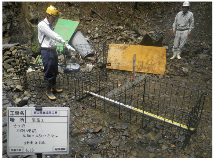
治山工事における監督業務（材料確認）の様子
