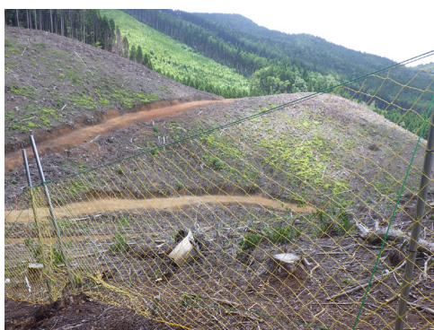
造林事業までが終わった作業現地
