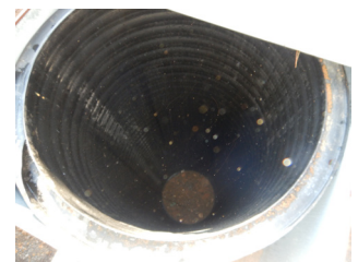
残渣処理施設の内部
