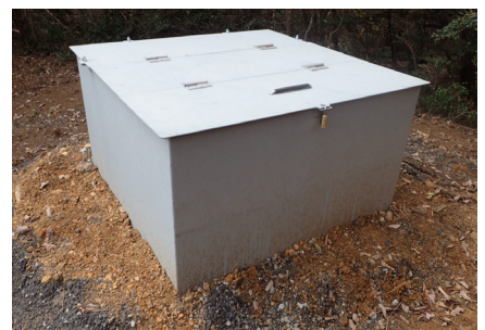
大型排水管完成時の外観
