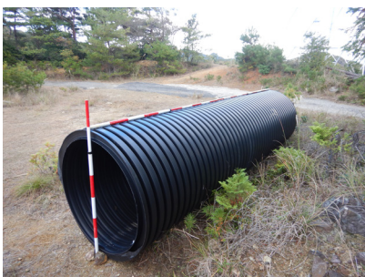
大型排水管（埋設前、サイズ確認）
