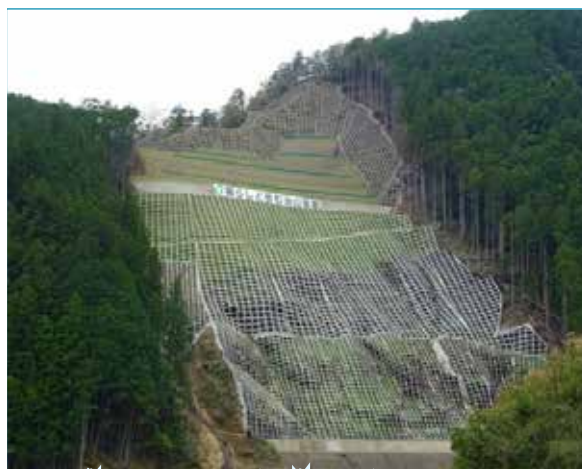
復旧工事完成（山腹工事）
