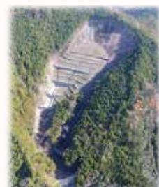
山腹工事施工後の様子
