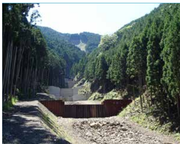
復旧工事完成（溪間工事）
