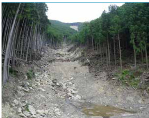
被害発生状況
