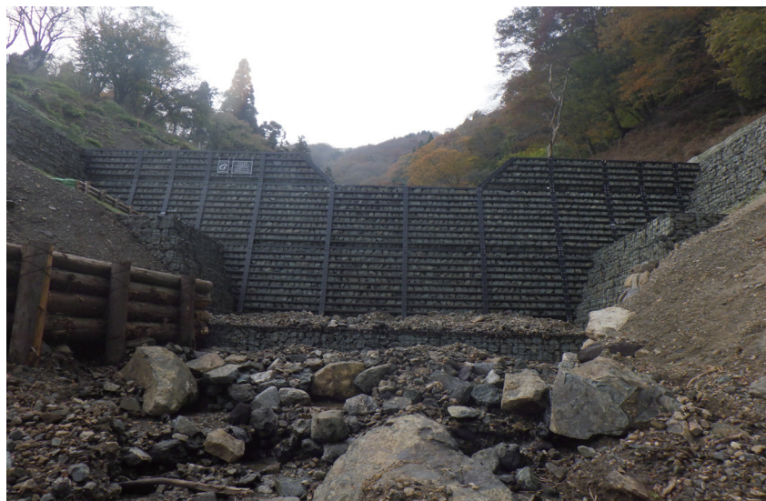
施工後の完成写真
