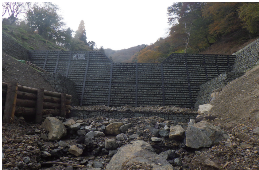
施工後の完成写真
