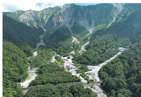
土砂の調節機能を持たせた治山ダム工（元谷）
