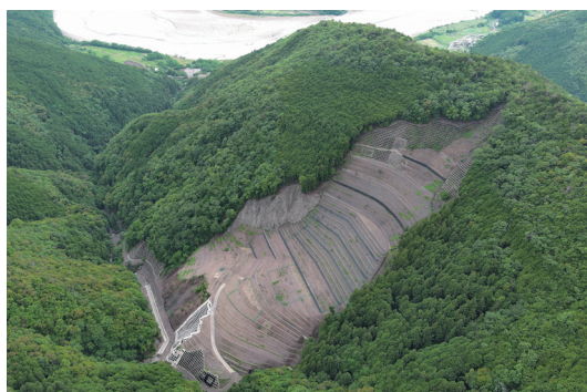
復旧が進む 下モ谷西側地区
