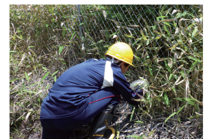
防護柵の点検
