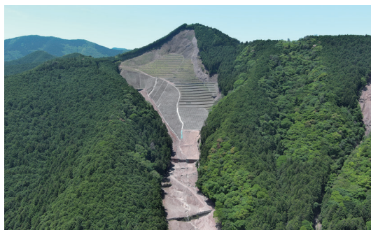
復旧が進む 上平治川地区
