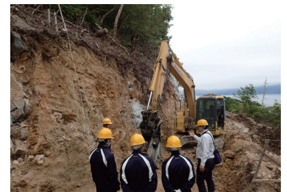
林業専用道施工現場の見学
