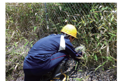
防護柵の点検
