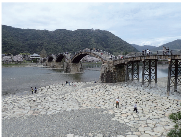
錦帯橋と城山 しろやま 国有林
