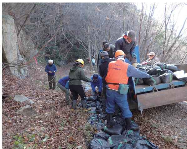
寂地山に至る林道整備の様子
