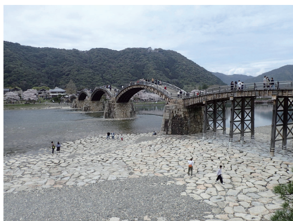
錦帯橋と城山 しろやま 国有林
