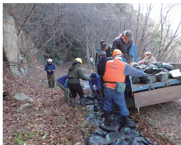
寂地山に至る林道整備の様子
