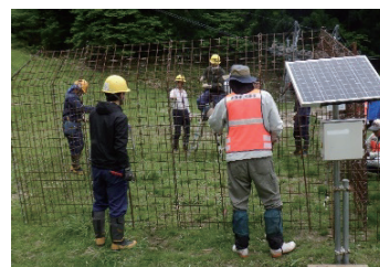
米原市との協定に基づく ICT 罠いわなの設置状況
